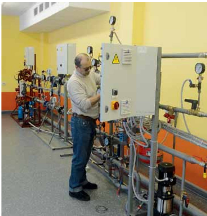
▲ Наладка учебно-демонстративного стенда системы теплоснабжения в Колледже городского хозяйства
