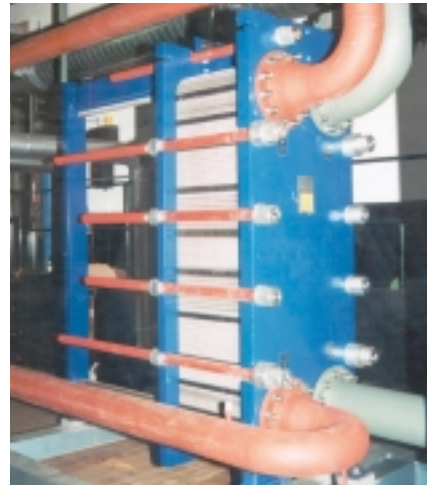
Рис. 2. Использование полусварного пластинчатого теплообменника в качестве испарителя на пивоваренном заводе.
