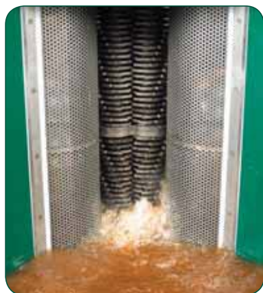
Сточные воды, поступающие в измельчитель Channel Monster.
